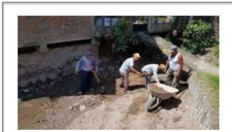
Figura N°03: Acarreo de material excedente
