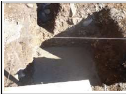
Figura N°04: Concreto F'C 140 kg/cm 2
