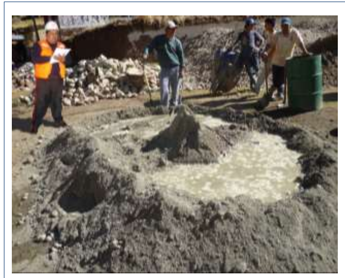
Figura N°18: Concreto f'c 210kg/cm2
