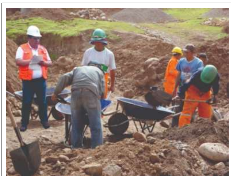
Figura N°15: Acarreo de material excedente
