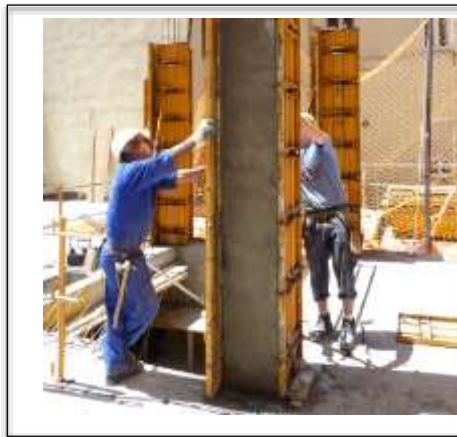
Figura N°07: Desencofrado
