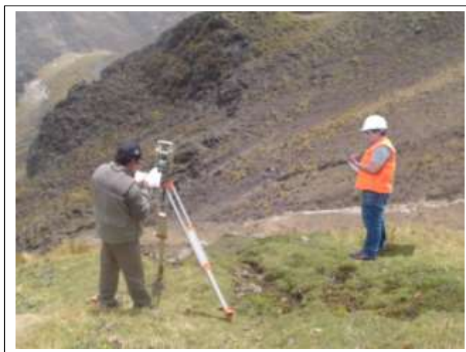
Figura N°13: Trazo y replanteo
