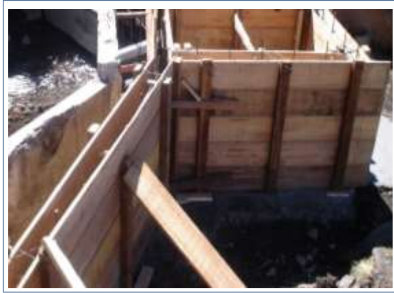
Figura N°21: Encofrado
