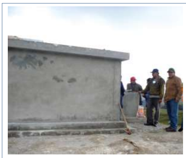
Figura N°19: Tarrajeo muros frotachado c/mort
