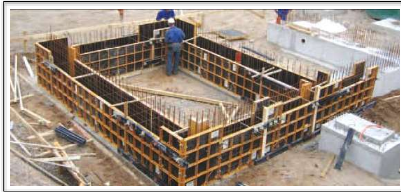
Figura N°06: Encofrado
