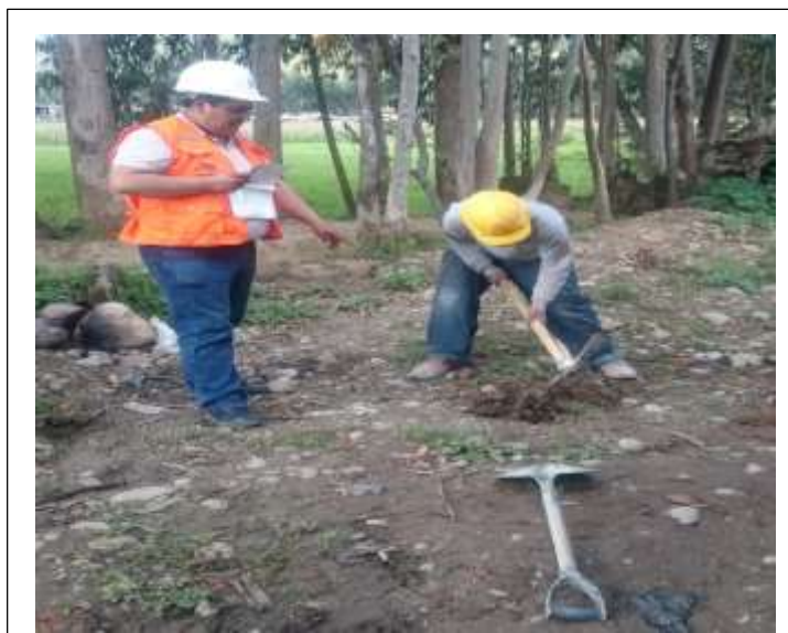
Figura N°14: Excavación manual en terreno normal
