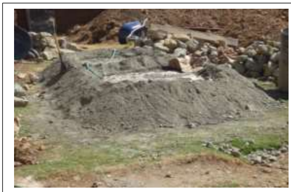
Figura N°16: Concreto f'c 140kg/cm2
