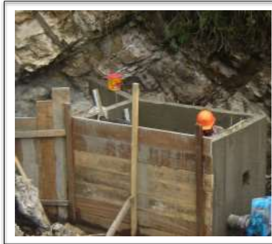
Figura N°22: Desencofrado
