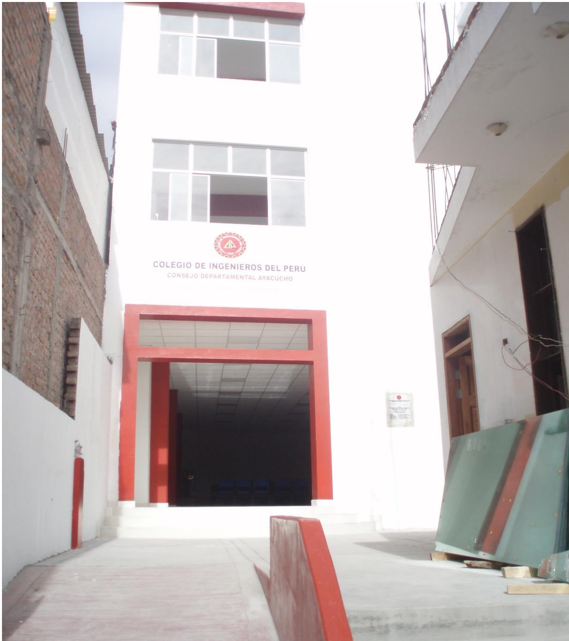
FOTO: 01 ELEVACIÓN PRINCIPAL DE LA EDIFICACIÓN, DONDE SE APRECIA LOS TRES NIVELES
