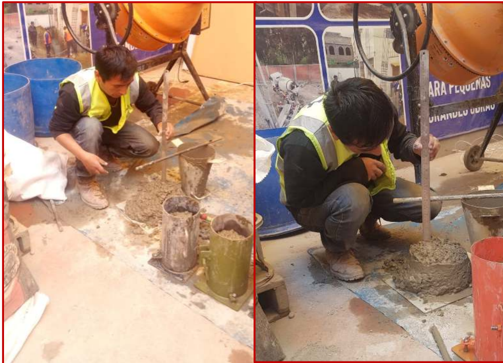
Figura 30: Control de consistencia del concreto
