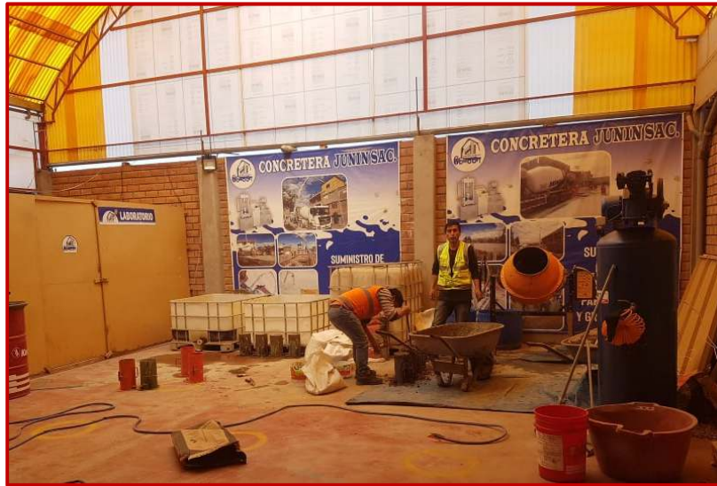
Figura 27: Elaboración de los testigos de concreto
