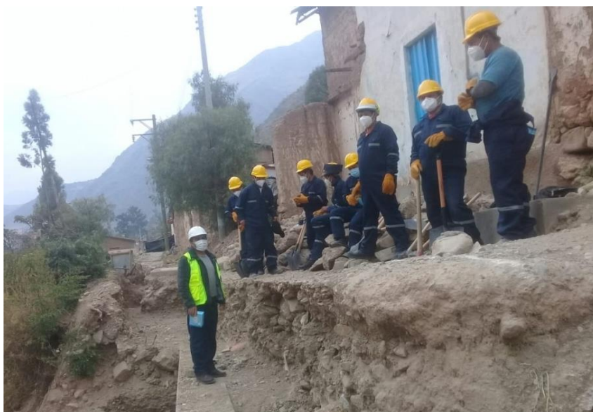
Foto N° 10: Capacitación al personal al inicio de la obra.
