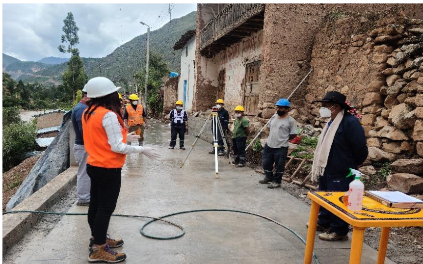
Fotografía 11: Capacitación durante el avance de la obra.
