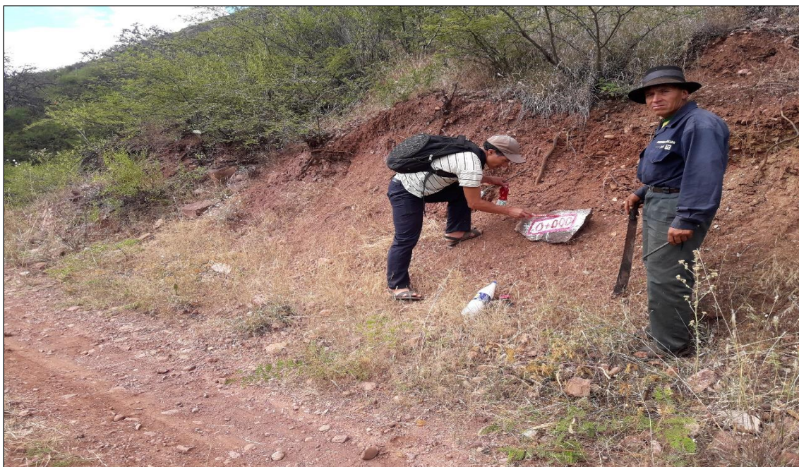
Fotografía 4: Vista de pintado de progresivas
