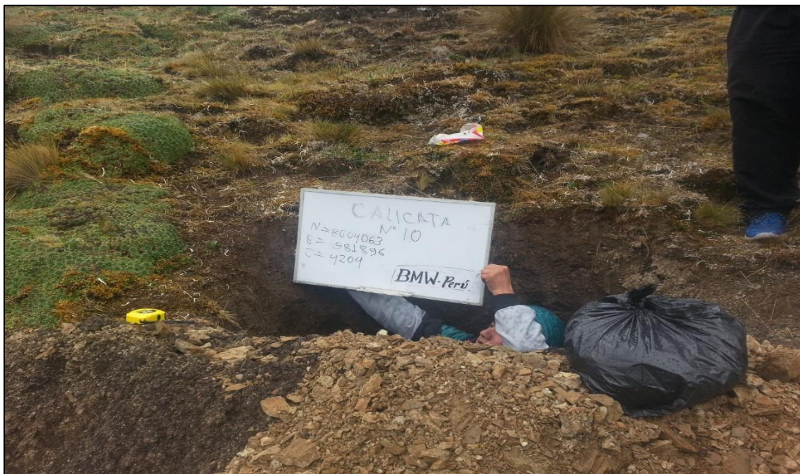
Fotografía 8: Vista de excavación de calicatas
