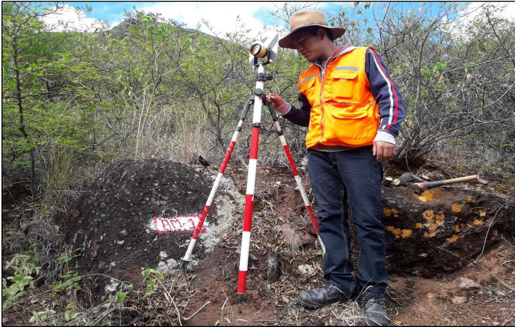
Fotografía 16: Colocación de BMs para el control de nivelación
