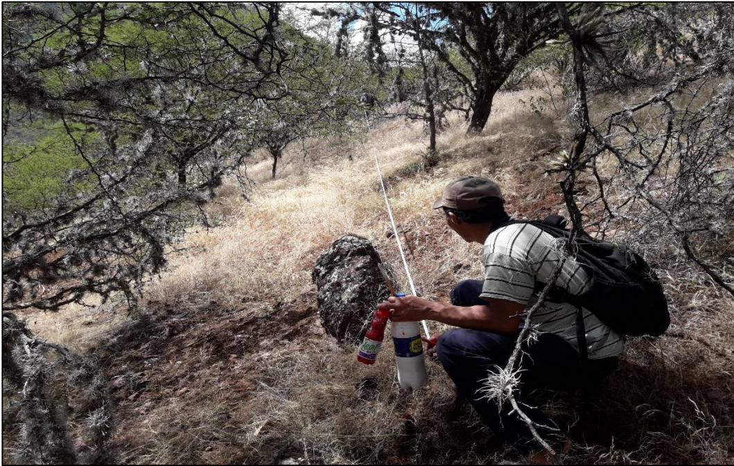
Fotografía 14: Trabajos de colocación de progresivas
