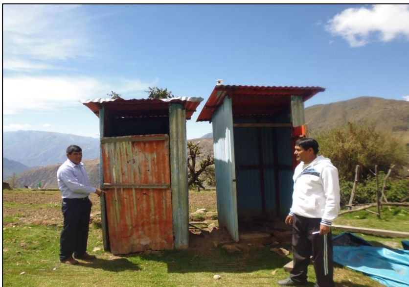
Fotografía 2: Letrinas sanitarias domiciliarias en Soyllullo
