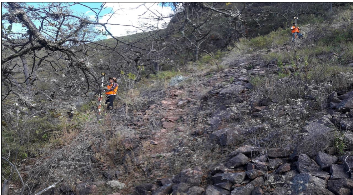
Fotografía 7: Vista de trabajos con prismas
