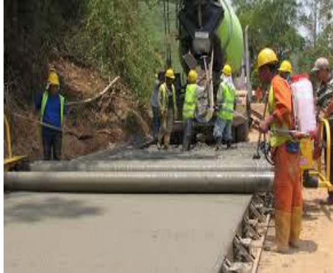
Nota. Trabajadores en pleno vaciado de concreto
