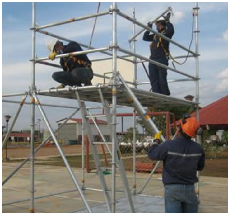
Nota. Armado de andamios en la empresa
